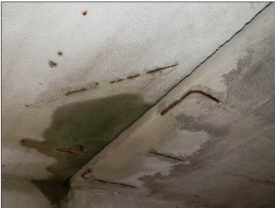
Obr. č. 11 - Detailní pohled na vybranou část nosné konstrukce - průsaky dilatační spárou, koroze výztuže a opadaná krycí vrstva.
