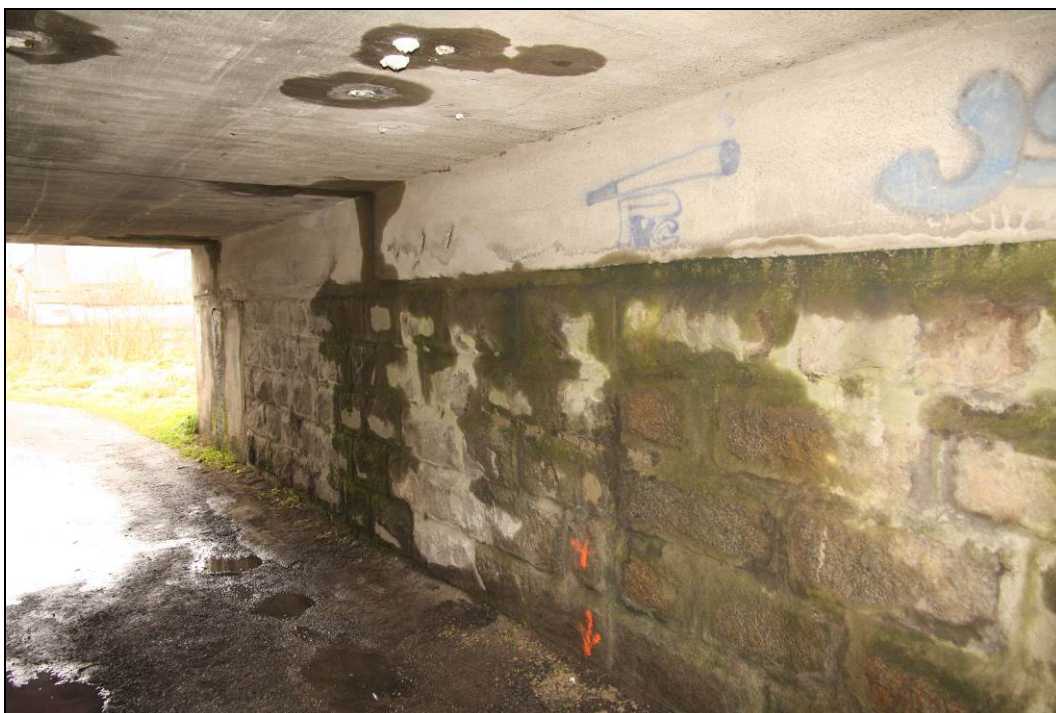
Obr. č. 12 - Detailní pohled na opěru Strakonice zleva - průsaky vody skrze dilatační spáry, průsaky mezi úložnými prahy a SS. Obdobná situace u opěry Nepomuk.
