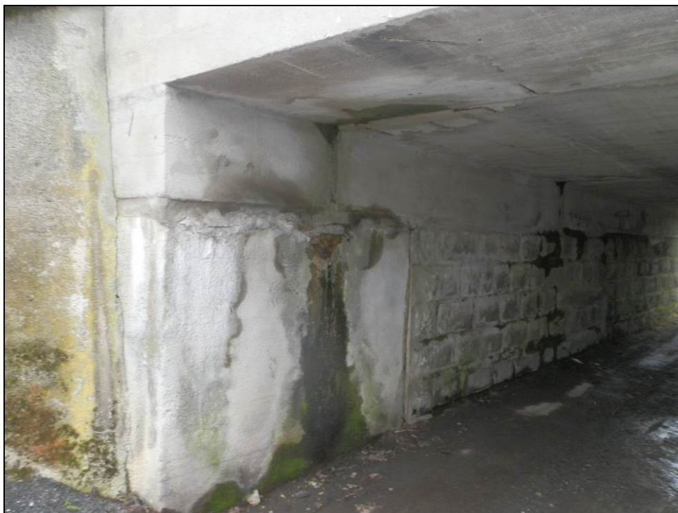
Obr. č. 13 - opěra Strakonice za pravý čelem - povrch betonu rozšíření opěry opadává a v líci jsou patrné průsaky vody.
