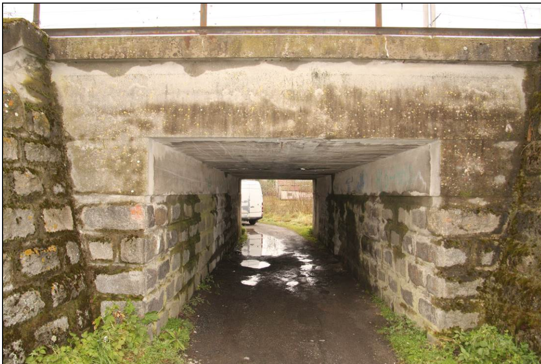
Obr. č. 9 - celkový pohled na vnitřní prostory mostu zleva - průsaky dilatačními spárami a pod úložnými prahy.
