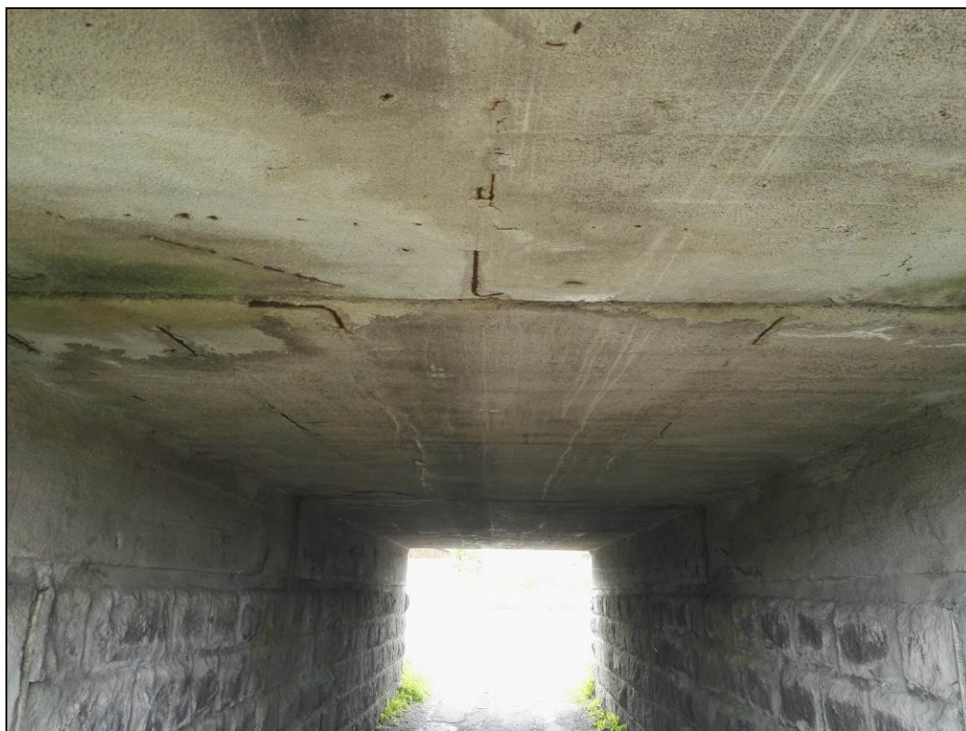
Obr. č. 10 - celkový pohled na nosnou konstrukci - ve spodním líci odhalena výztuž zasažena celoplošnou korozí.
